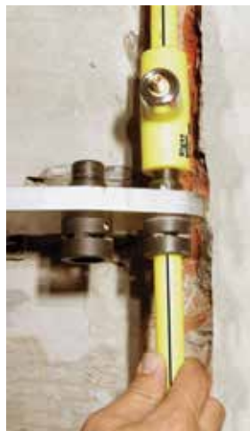
Thermofusión en la canaleta.
