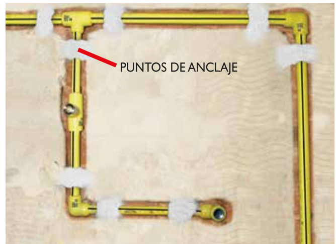
Vista parcial de instalación.
