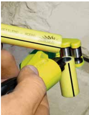
Corte con corta-tubo en obra.
